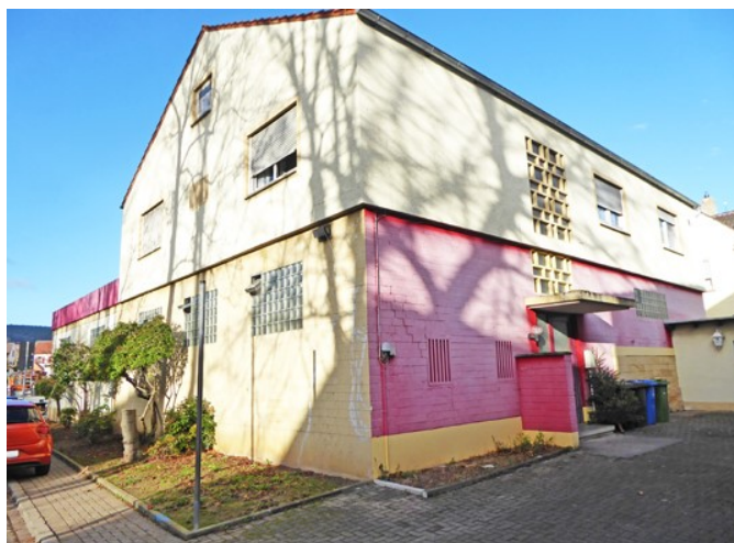
Altes Feuerwehrhaus der Stadt Deidesheim (Bild: MH-Infoline)
