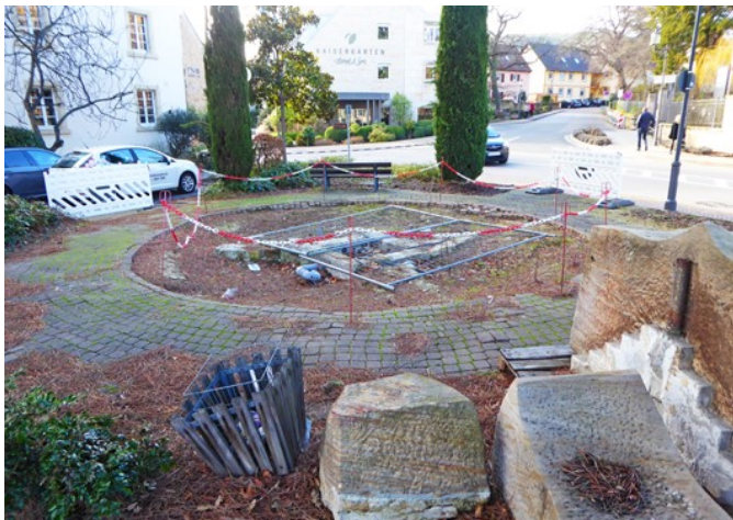
Die „ewige“ Baustelle am Kaisergartenbrunnen (Bild: MH-Infoline)
