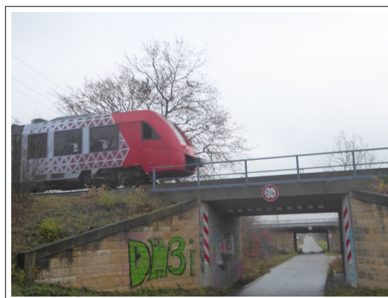
Teilstück der geplanten, aber abgelehnten Rollskistrecke zwischen Forst und Niederkirchen. Bild: MH-Infoline.
