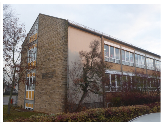
Grundschule Meckenheim. Bild: MH-Infoline.
